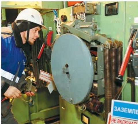
Регулировка привода высоковольтного выключателя 10 кВ
